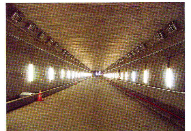
坑内照明器具取り付け状況
